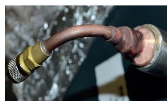
**Schraderventil:** Unter Druck stehendes System - bei Montage der weiterführenden Leitungen ist eine einfache Dichtheitsprüfung möglich.
